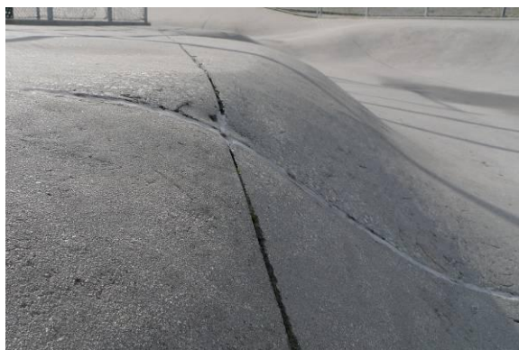
"Hoppkanten" flater ut på det kritiske toppstykket, og mister dermed sin nødvendige "sprett".
